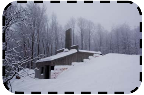
Der Rohbau des neuen Heizhauses im tiefen Winterschlaf!
